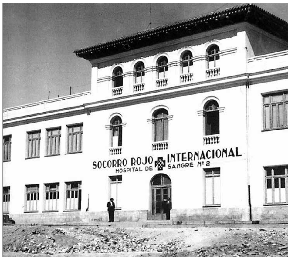
"Edifici del Grup escolar de la partida dels Àngels, promogut per E. Gómez Serrano. No va arribar a funcionar a causa de la guerra, en la qual fou hospital de sang i després hospital militar."
