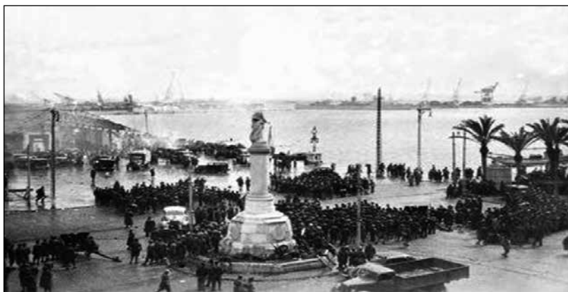
Desallotjament del port d'Alacant per part de les tropes italianes.
