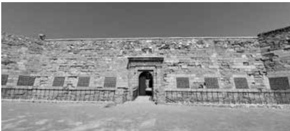
Prisión de Victoria Grande. Lugar donde Carlota O'Neill escribe Romanza de las rejas. Estado actual de la entrada. Fotografía: Cándida Rodríguez. 17/07/2023.
